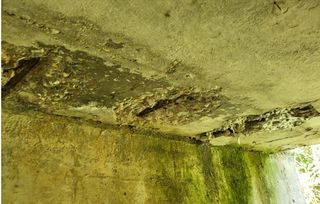
Abb. 3: Blick auf die Brückenunterseite mit freiliegender korrodierter Längsbewehrung, Betonabplatzungen mit Aussinterungen
