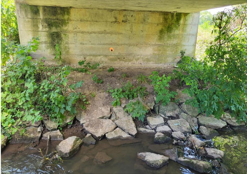
Abb. 13: Kolkschutz der Widerlagersteinschüttung an beiden Widerlagern ausgespült und ausgebrochen
