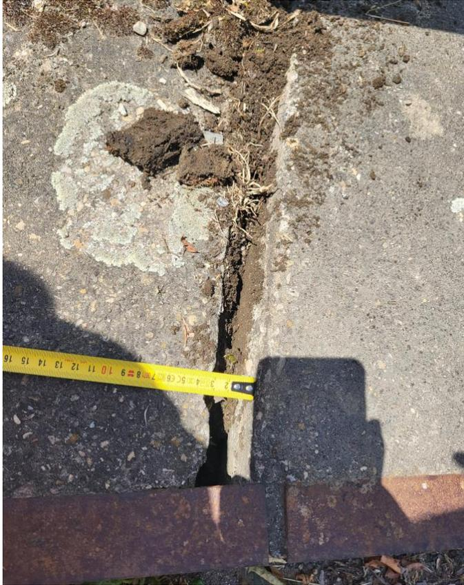
Abb. 9: Große Betonabplatzungen an den Kappenrändern mit Bewuchs und korrodierter Stahleinfassung
