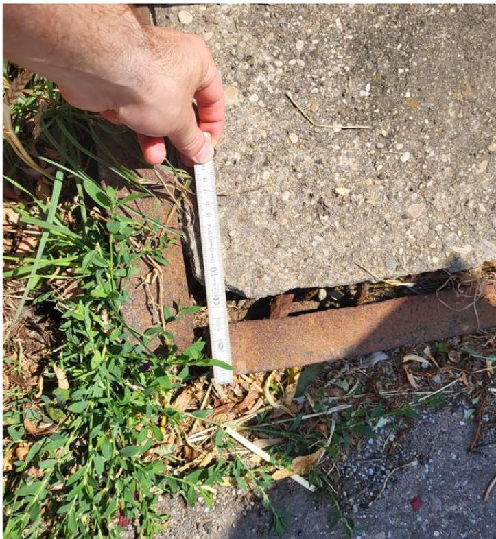
Abb. 8: Große Betonabplatzungen an den Kappenrändern mit Bewuchs und korrodierter Stahleinfassung
