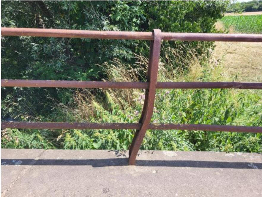
Abb. 11: Korrodiertes Geländerpfosten mit Anprallschaden
