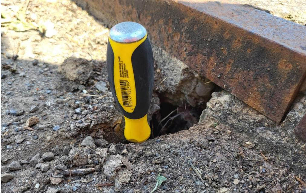
Abb. 7: Gesamter Fahrbahnübergang mit Abschlussprofil schadhaft ausgebrochen und offen
