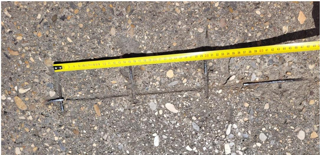
Abb. 12: Stellenweise Risse und Belagsausbrüche mit freiliegender Bewehrung im Fahrbahnbelag / Walzasphalt
