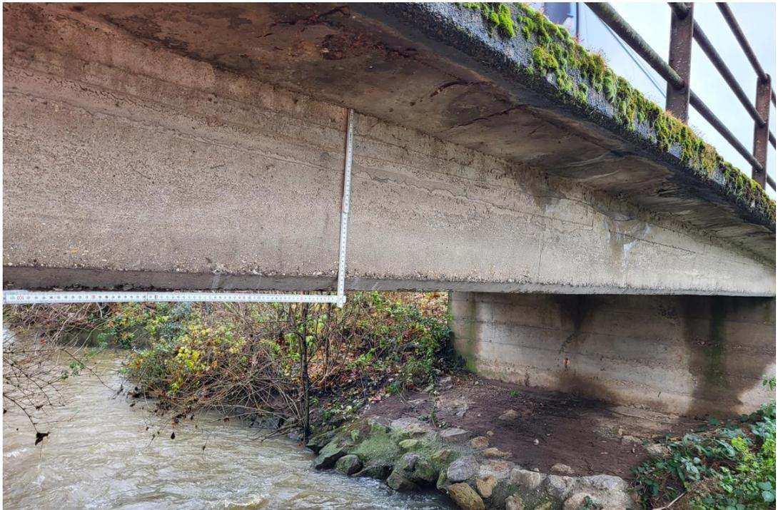
Abb. 5+6: Durchfeuchtete Auflagerbank und Widerlagerwand mit Wasserstau
