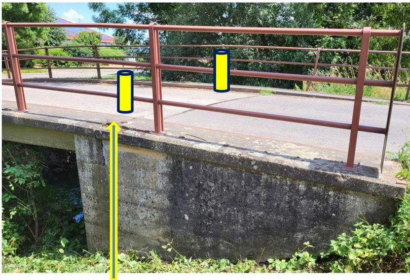
Abb. 20: Ansicht der alten Brücke mit Markierungen für die insgesamt 4 gelb markierten Kernbohrungen  $\geq$ DN200mm zum Durchführen der Tragschlaufen des Autokranes kurz vor den beiden Endquerträgern, um den Plattenquerschnitt zu umschließen und ausheben zu können.
