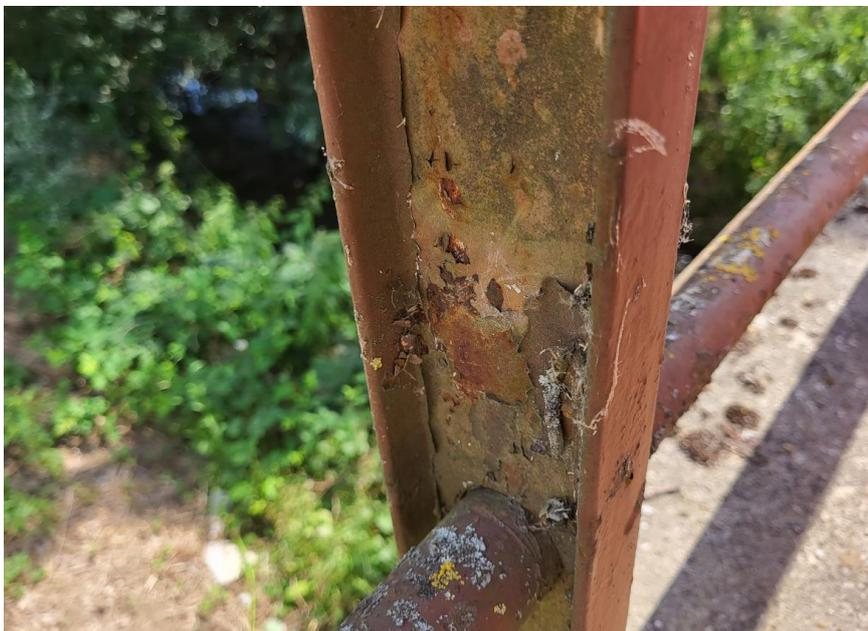
Abb. 10: Korrosion mit abwitternder Beschichtung an gesamter nicht mehr normkonformer Geländerkonstruktion
